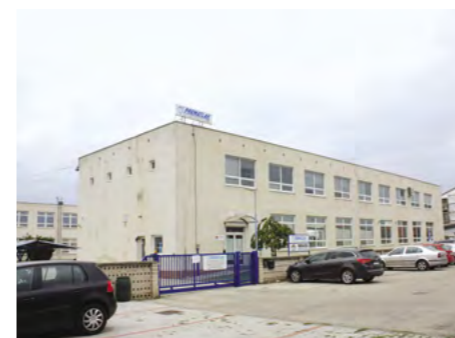
Vstup do areálu pred rekonštrukciou
