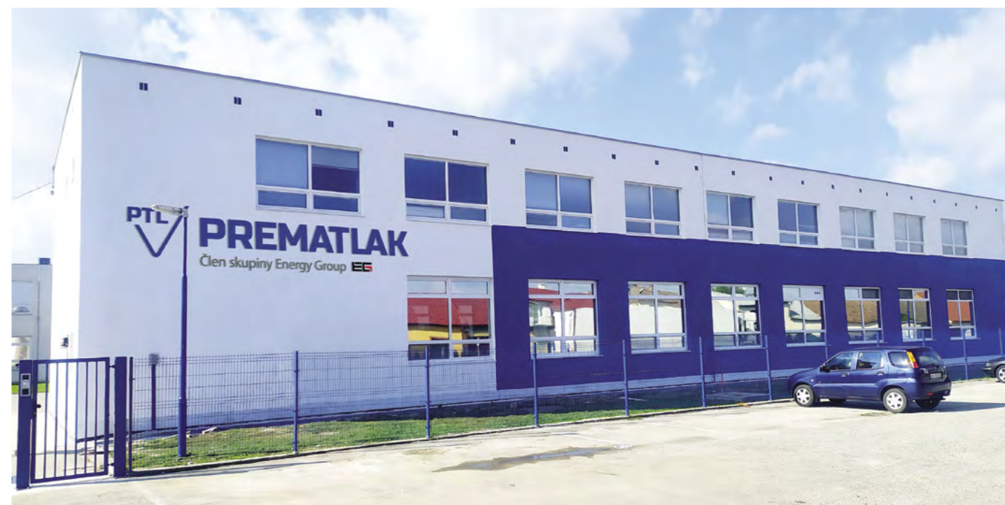
Vstup do areálu po rekonštrukcii
